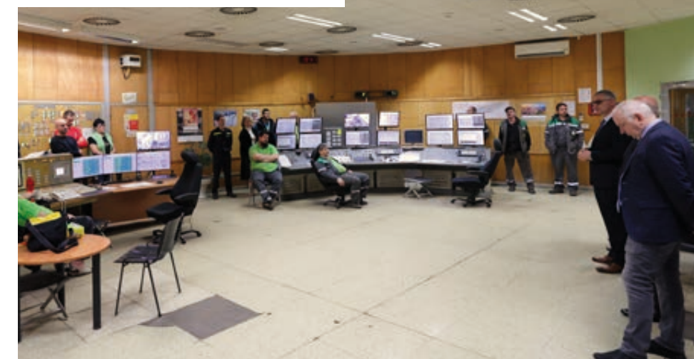
V elektrárně Chvaletice. Foto: 3x (pim)
