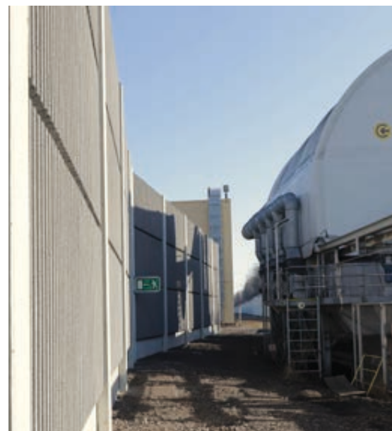
Protihluková stěna má únikové dveře. Foto: (pim)
